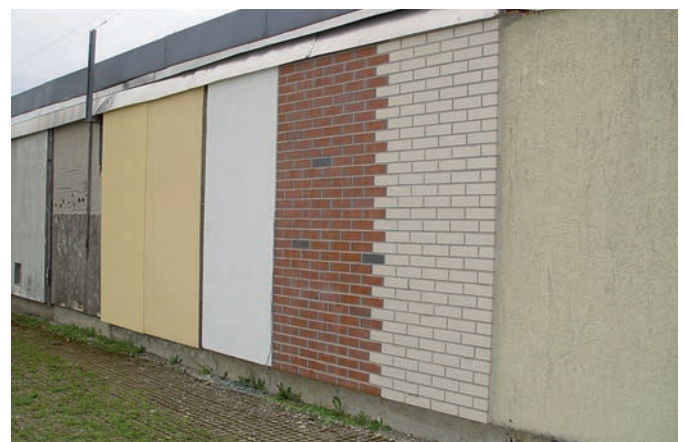
Bild 10. Die auf dem Freigelände des Fraunhofer-Instituts für Bauphysik in Holzkirchen angelegten WDVS-Wandflächen mit Deckschichten aus Putz, roten und weißen Klinkerriemchen
